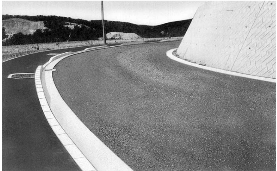
継手箇所を少しずつ曲げて布設
