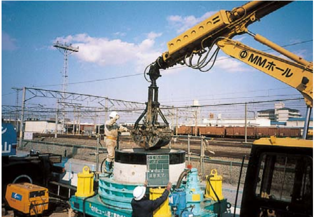
掘削、圧入状況
