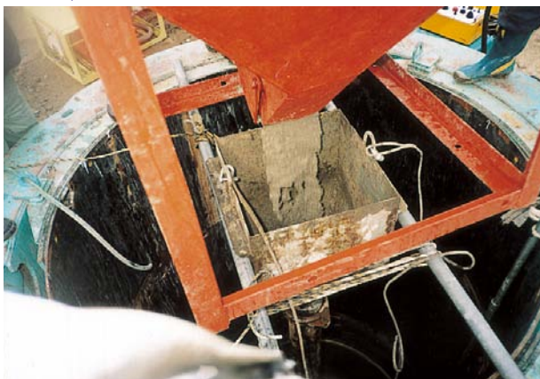
底盤コンクリート打設
