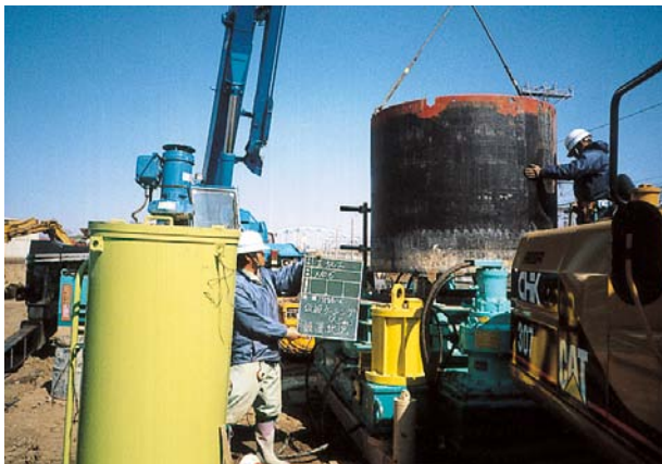
仮設ケーシング据付
