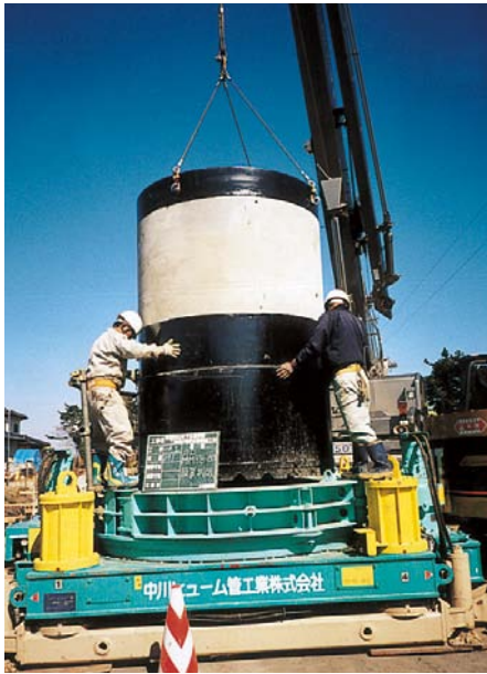
刃口、側塊設置
