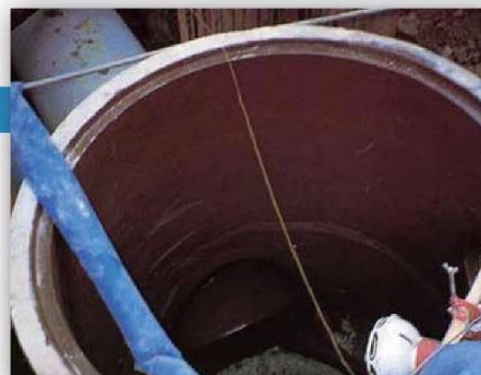
組立マンホール
