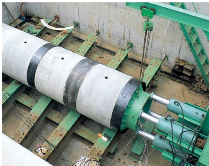
推進用大変位CSパイプ 軸力試験
