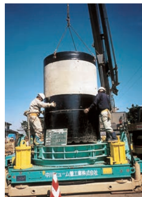
② 刃口、側塊設置
