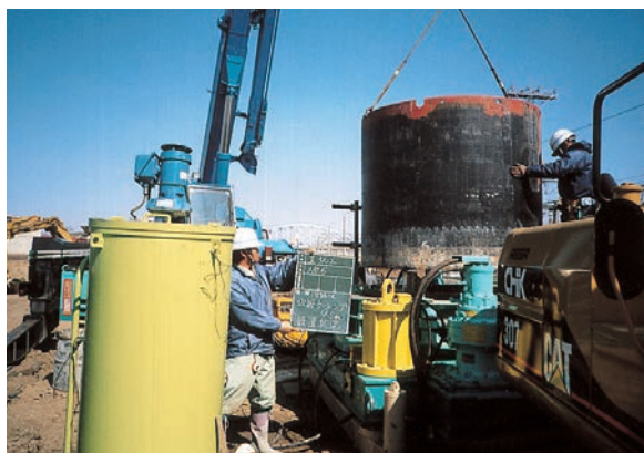
⑤ 仮設ケーシング据付
