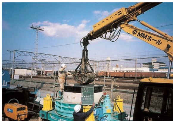
③ 掘削、圧入状況
