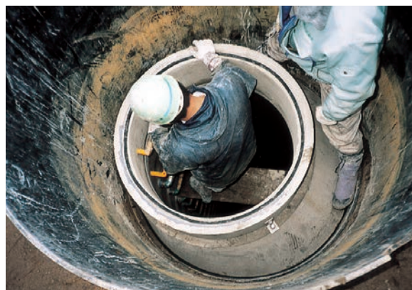
⑧ 人孔設置
