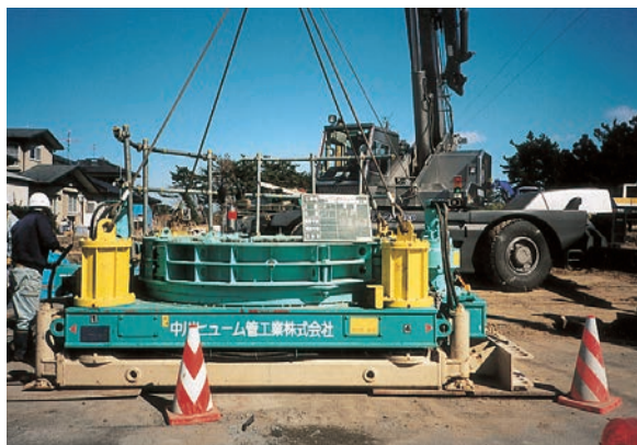
① 圧入機据付設置
