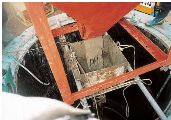
⑥ 底版コンクリート打設
