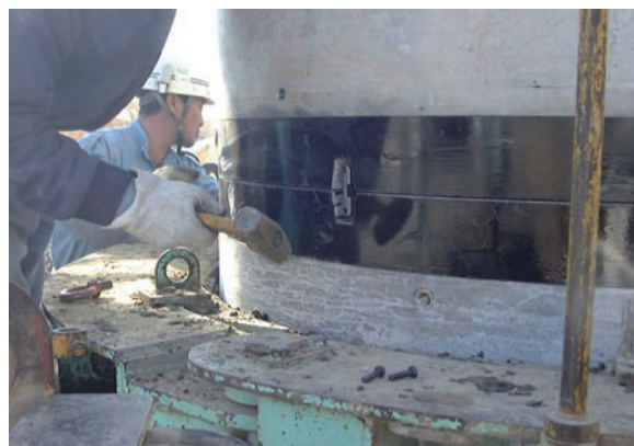
④ 側塊接合状況
